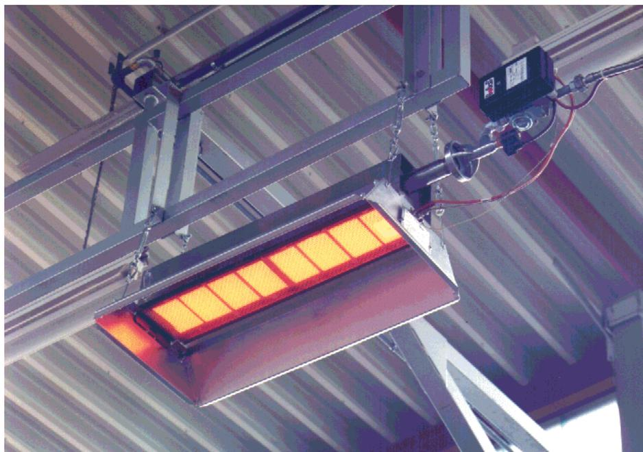
Источником энергии для горелки газовой инфракрасного излучения служит природный или сжиженный газ. Излучение попадая на различные предметы, кожу и одежду человека, преобразуется в тепловую энергию, что позволяет поддерживать более низкие температуры воздуха в помещении и сокращать потери тепла при сохранении комфортных условий.
